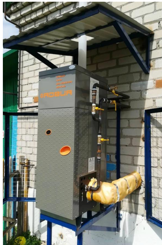
Использование наружных котлоагрегатов настенного исполнения
