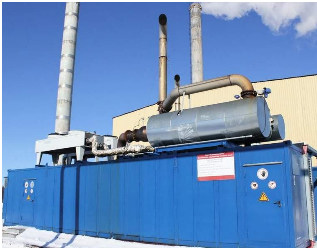
Мини-ТЭЦ на базе газопоршневой установки
